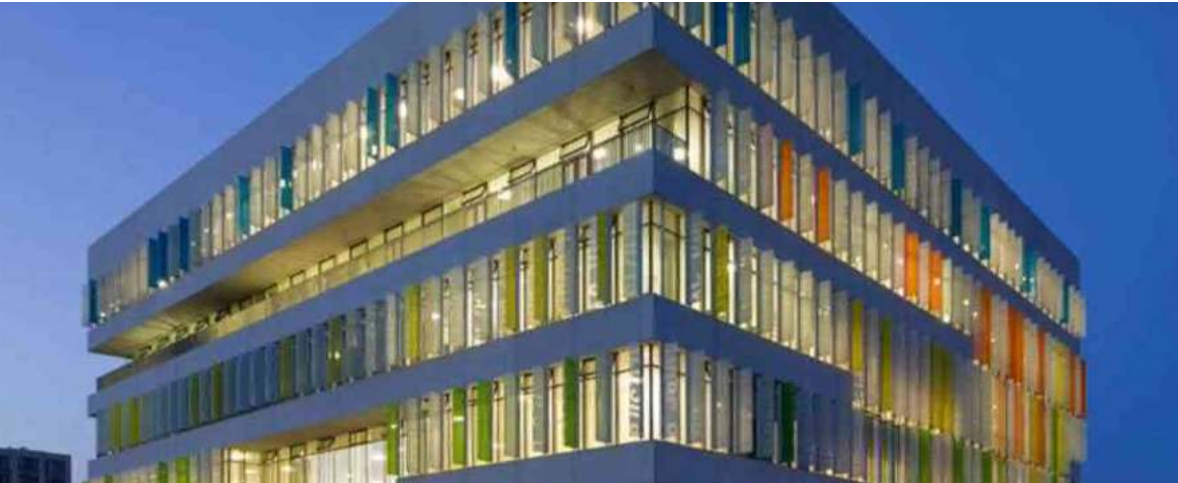
Außenansicht der Schule
