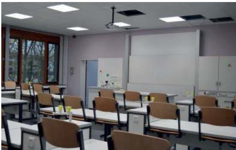
Abb. 02 | Säuleninstallation (Helene Lange Schule, Frankfurt)
